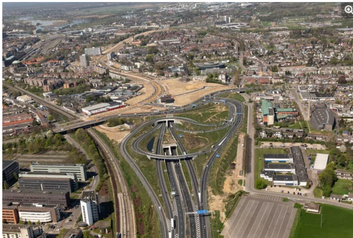
De Koning Willem-Alexandertunnel in april 2018.
